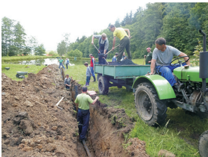
Budování nového přívodu vody, foto: P. Matějka
